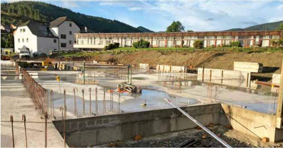
Die Bauarbeiten sind in vollem Gange, eröffnet wird im Sommer 2022.
