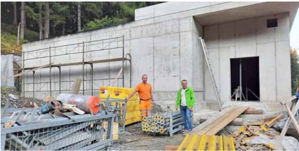
Bgm. Fritz Sperl und Klaus Maierhofer beim neuen Hochbehälter.
