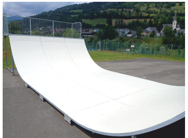
Sanierung Skaterpark in Eigenregie
