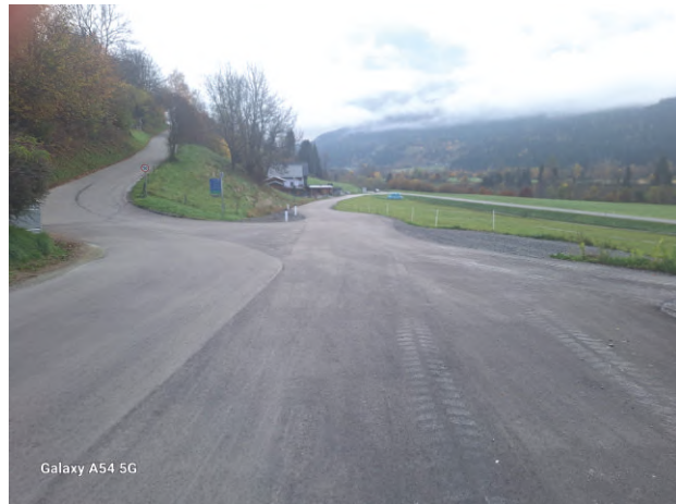
Ortseinfahrt St. Georgen Ost
