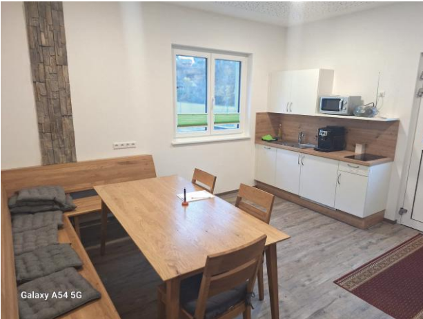
Umbau Bauhofgebäude, Küchengebäude, Sanitäranlagen
