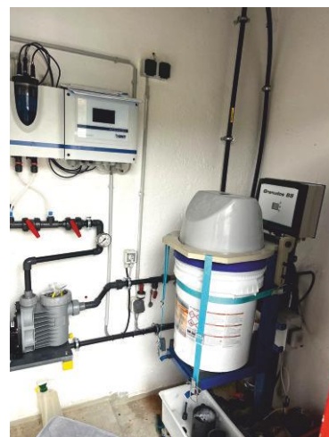
Neue Dosieranlage Freibad.
