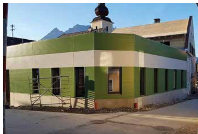
Neubau Firma Weinhandlung Hofer
