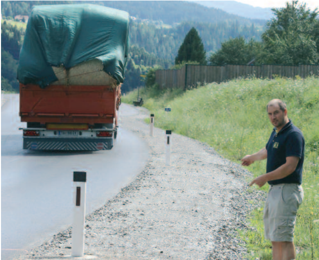
Sanierte Straße inkl. dem Gehbereich auf der rechten Straßenseite
