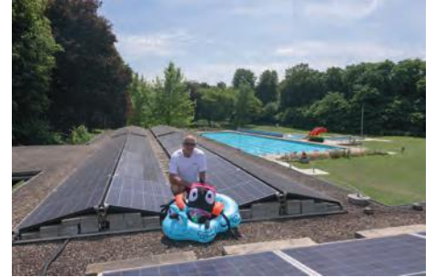
Bademeister Reinhard Leitgeb und Edgar begutachten die PV-Anlage beim Rosenbad
