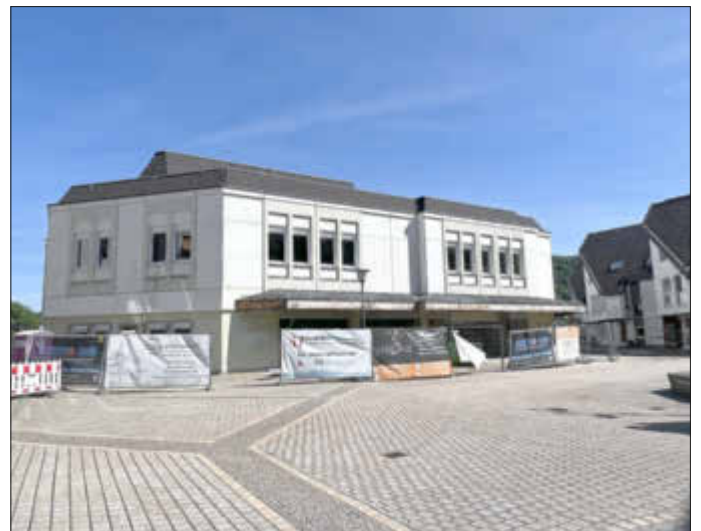
Zwar laufen am neuen Standort im Nahe-Center 13-14 noch die Bauarbeiten, aber bereits im Juli soll der Umzug erfolgen.
