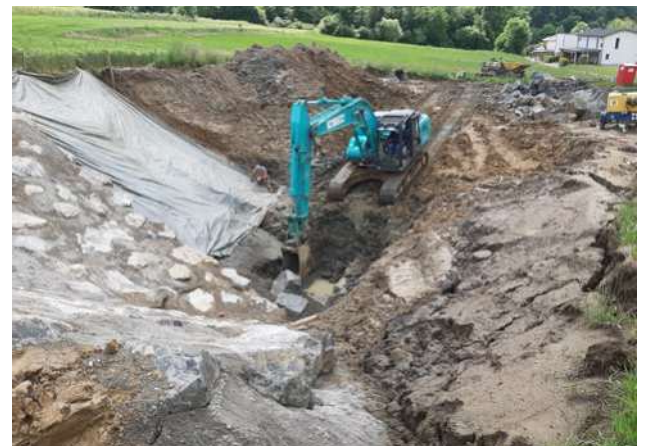
Hangsicherung beim Hangwasserbecken „Köhlerweg“
