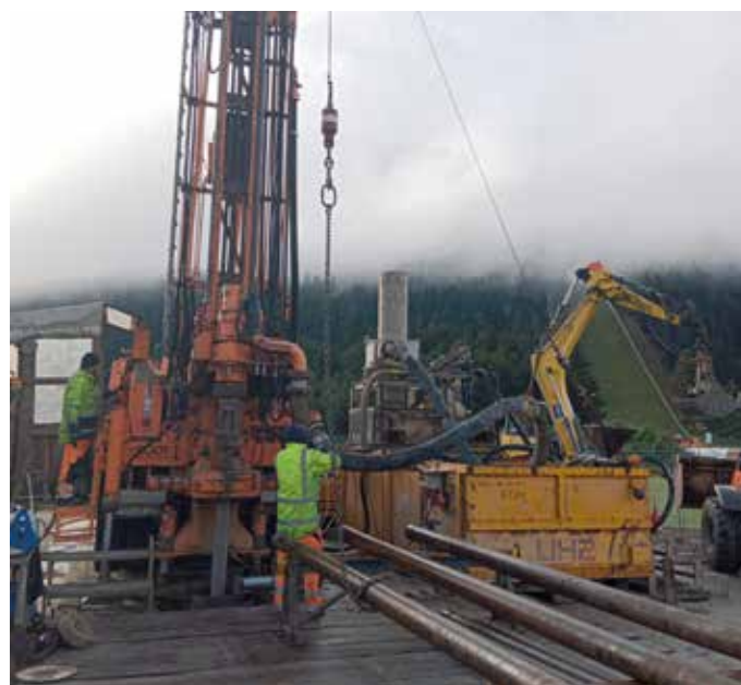
Errichtung eines zweiten Tiefbrunnens für die Wasserversorgungsanlage Tauplitz.
