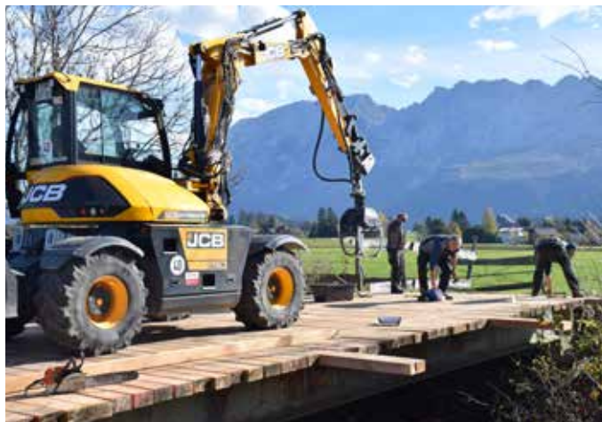
Auch die Loipenbrücke beim Campingplatz wurde fit für den Winter gemacht.
