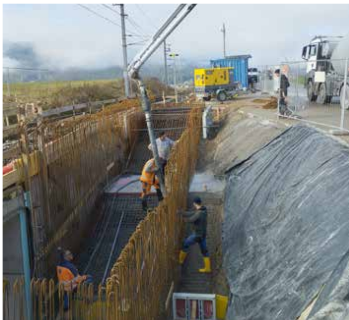
An der Fertigstellung der neuen Gehwegunterführung – Kranawald wird mit vereinten Kräften gebaut.
