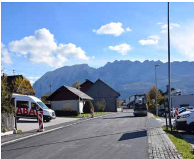
Die Westeinfahrt (Billa bis Abzweigung Neuhofen) wurde vom Land Steiermark und der Marktgemeinde Bad Mitterndorf (Gehsteige € 144.000,-) fertig saniert.
