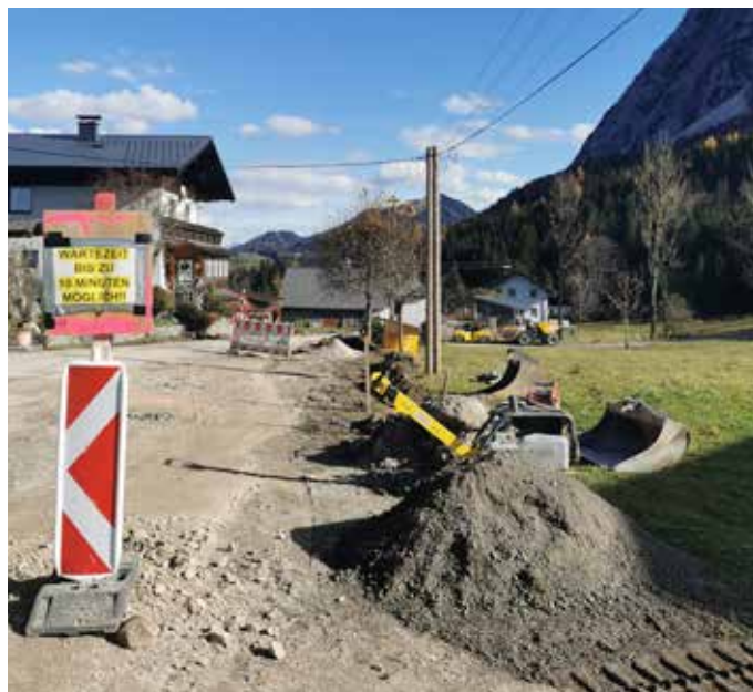
Auch an der Sanierung der Kulmstraße wird fleißig gearbeitet, Fertigstellung noch in diesem Jahr.
