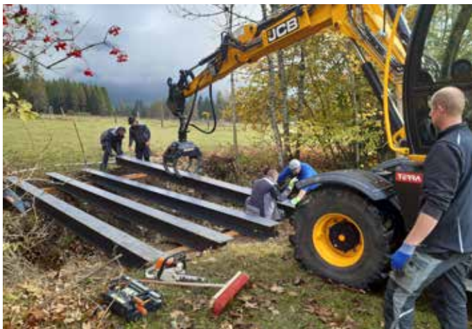
Loipenbrückensanierung bei der Freibergloipe.
