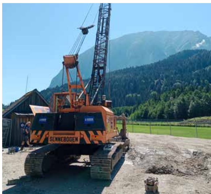
Errichtung eines zweiten Tiefbrunnens für die Wasserversorgungsanlage Tauplitz.
