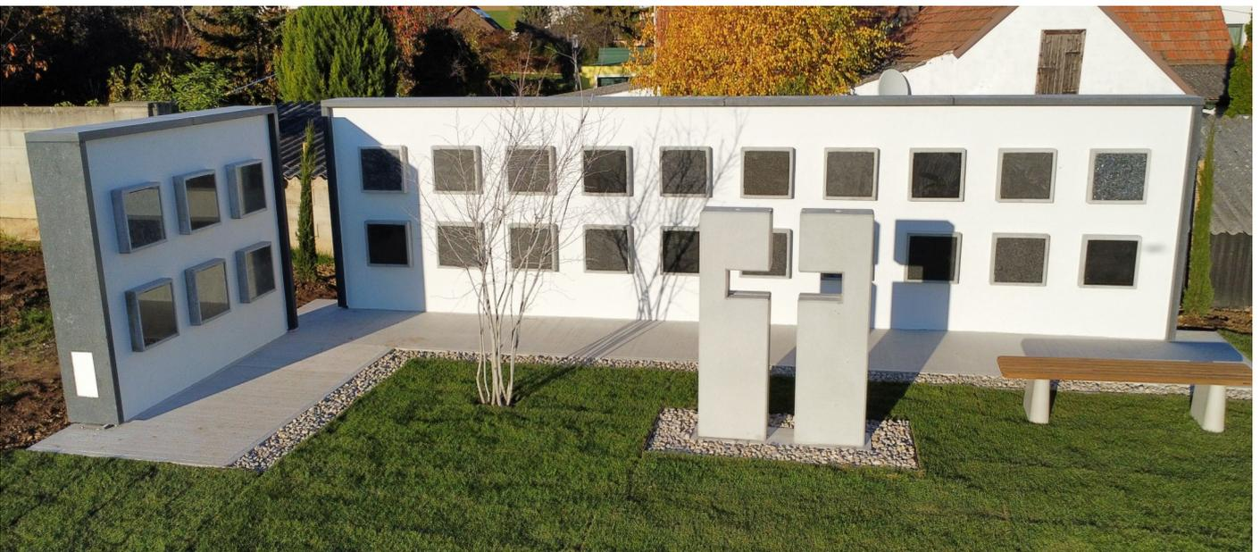
Die Errichtung einer Urnenwand im örtlichen Friedhof wurde umgesetzt. Die beleuchtete zweiteilige Urnenwand verfügt über 26 Nischen mit verschiedenen Granitabdeckungen. Die Wand ist derart gestaltet, dass sie bei weiterem Bedarf an Nischen - in gespiegelter Form - erweitert werden kann. Die Gesamtkosten - mit notwendigem Mehraufwand - betragen € 98.499,18.
