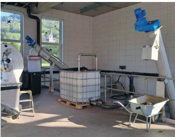
Mechanische Vorreinigung und Klärschlammwässerung
