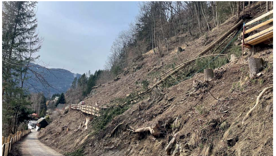
Anfang März wurden die Arbeiten für die Errichtung des Steinschlagschutzes in Lind fortgesetzt. Bis Mitte des Jahres soll das Bauwerk, welches auch Hubschrauber Einsätze erfordert, fertig gestellt sein. Investitionskosten ca. € 500.000,--
