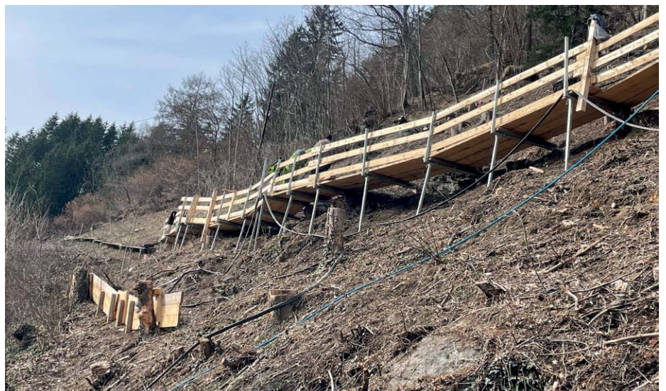
Anfang März wurden die Arbeiten für die Errichtung des Steinschlagschutzes in Lind fortgesetzt. Bis Mitte des Jahres soll das Bauwerk, welches auch Hubschrauber Einsätze erfordert, fertig gestellt sein. Investitionskosten ca. € 500.000,--
