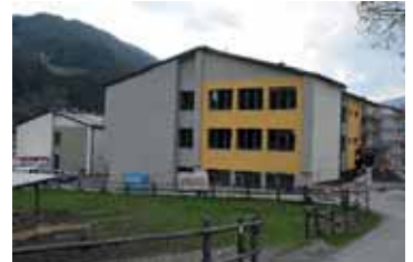
Diese Großbaustelle in der Marktgemeinde St. Peter a. Kbg. wird bald abgeschlossen sein, die Mittelschule ist neu saniert.
