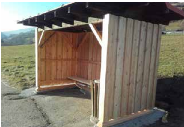
Perfekte Reparaturarbeit von Mitarbeiter Klaus Jeray
