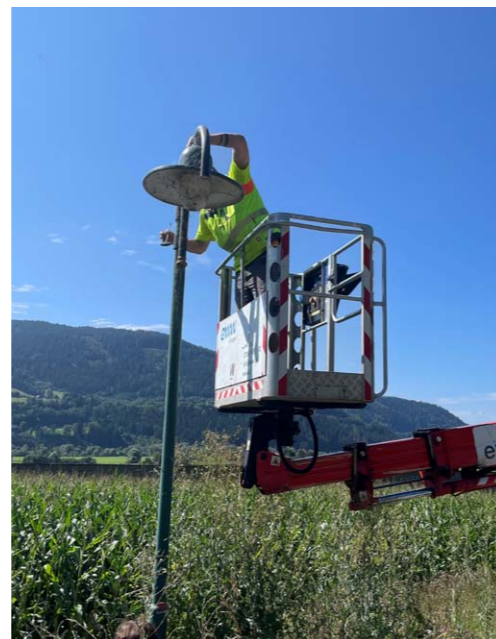
Der Austausch der Straßenlaternen sollte bis Ende Oktober abgeschlossen sein.
