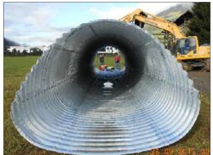
Erschließung des Gewerbegebietes mittels Wellstahldurchlass über den Mühlbach
