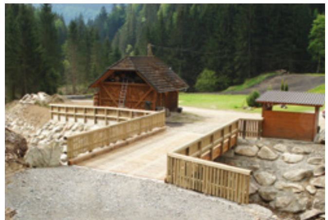
Maßnahmen im Bereich der Trafostation
