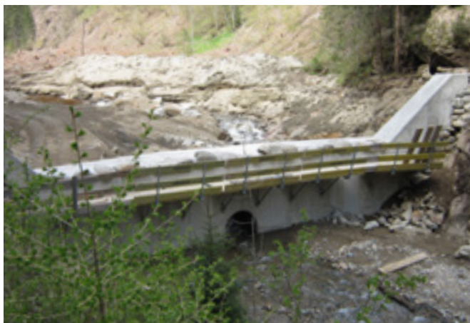
Sanierung der Bogensperre
