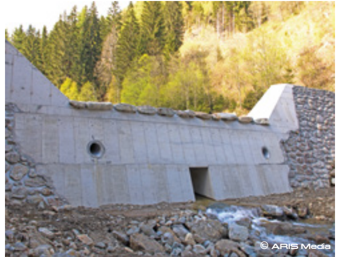
Sanierung der Sperre in hm 180,34
