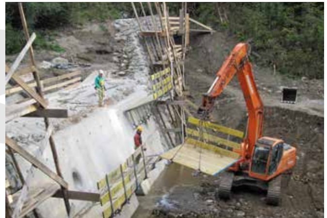
Sanierungsarbeiten an der hinteren Steinsperre im Grabeninneren
