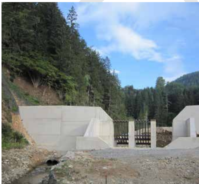
Gchiebesperre am Grabenausgang – Sperrenmitteiles mit rechtsufrigen Flügel
