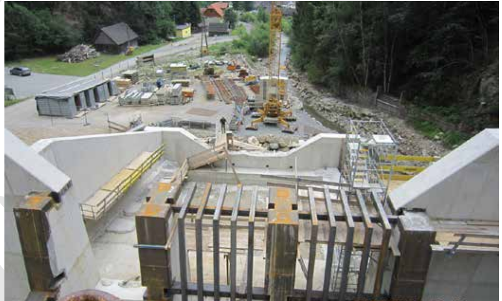
Bau des Sperrenmitteiles bei der Gchiebesperre am Grabenausgang
