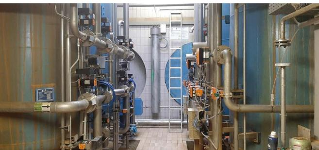
Diese Vorklärstation gehört übrigens dringend saniert. Nach der Grobreinigung kommen die Abwässer in ein 800 qm fassendes Belebungsbecken, in dem mittels Turbine Sauerstoff zugeführt wird. Das geklärte Wasser fließt an die Oberfläche und wird in den Schönungsteich geleitet. Zuvor wird noch der Schlammanteil davon getrennt.
