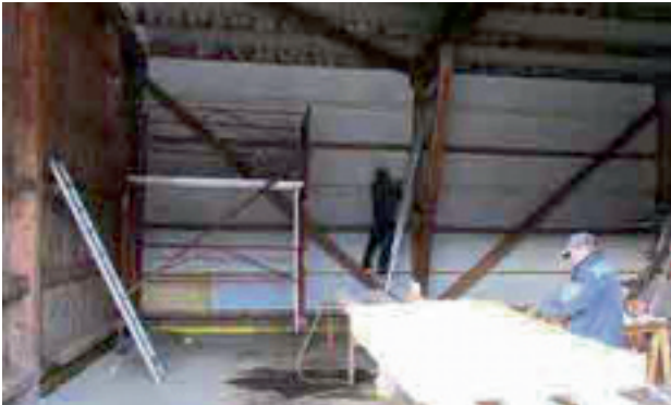
Betriebsgebäude am Bauhof
