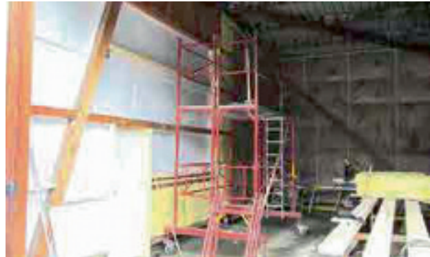
Garagenneubau am Bauhof
