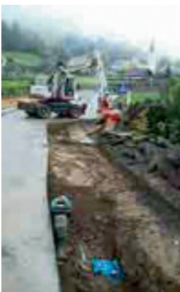
Gehwegsanie rung der Kreischbergstraße
