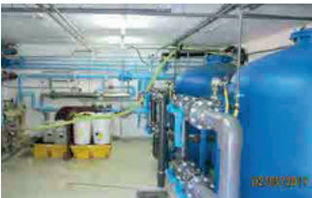
Neubau der Filterstation im Freibad
