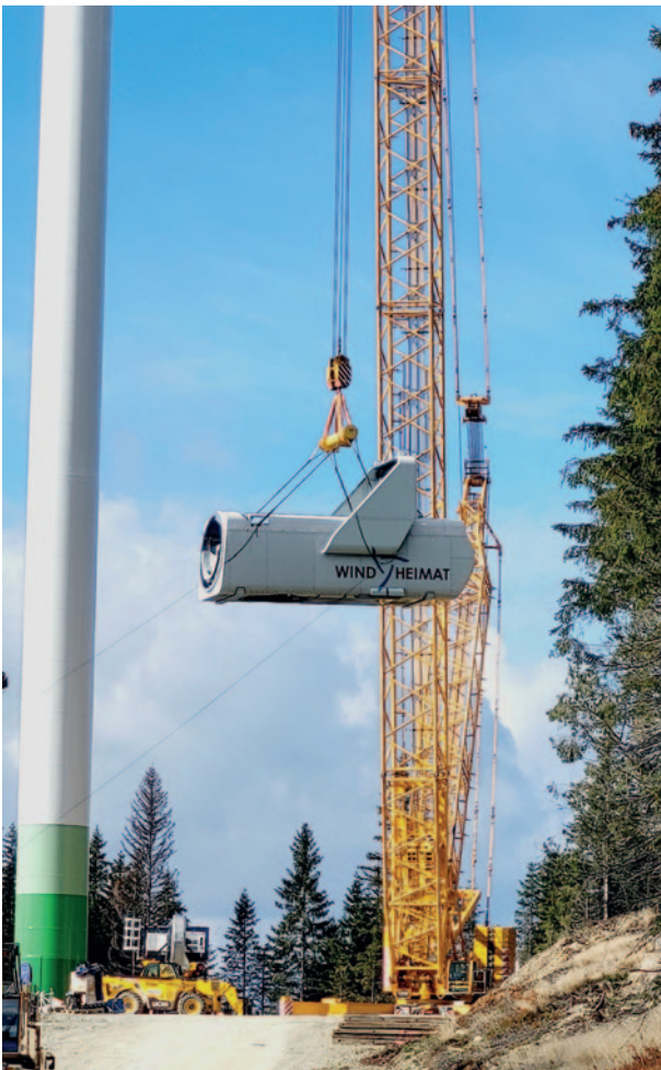
Fotos: E-Werk Kindberg; Errichtung der Windkraftanlagen für die Windpark Stanglalm GmbH
