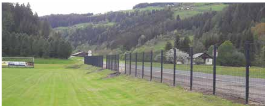
Der neu errichtete Zaun in Richtung Parkplatz
