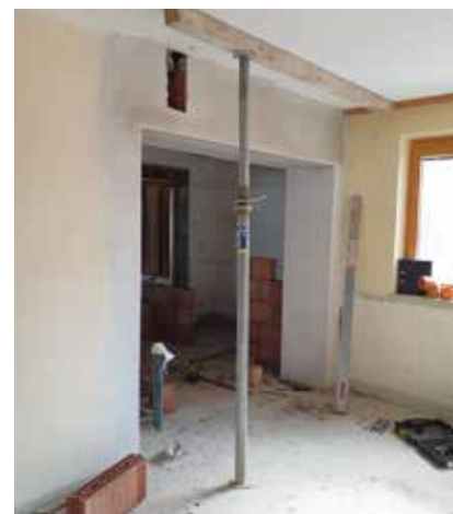
Neuer Durchbruch in Küchen- bzw. Barbereich
