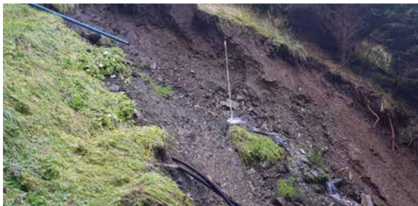
Die abgerutschte Quellfassung in Bretstein
