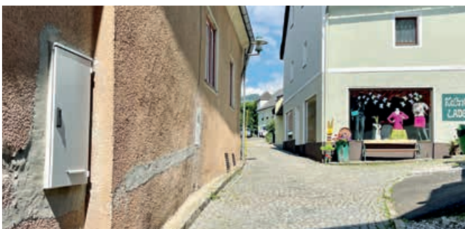
Neuer Stromkasten in der Sattlergasse
