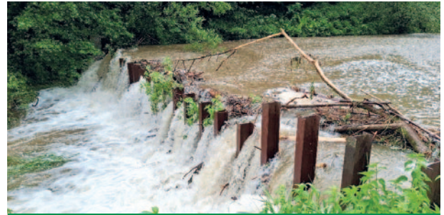
Rückhaltebecken Stollingbach – Grobrechen – vorher
