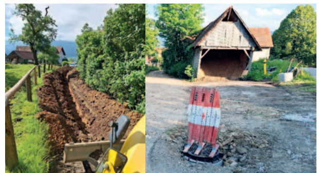
Entwässerungsmaßnahmen am Wiedenberg
