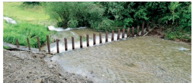
Rückhaltebecken Stollingbach – Grobrechen – nachher
