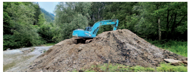
Rückhaltebecken Stollingbach – Grobrechen – nachher – Materialaushub
