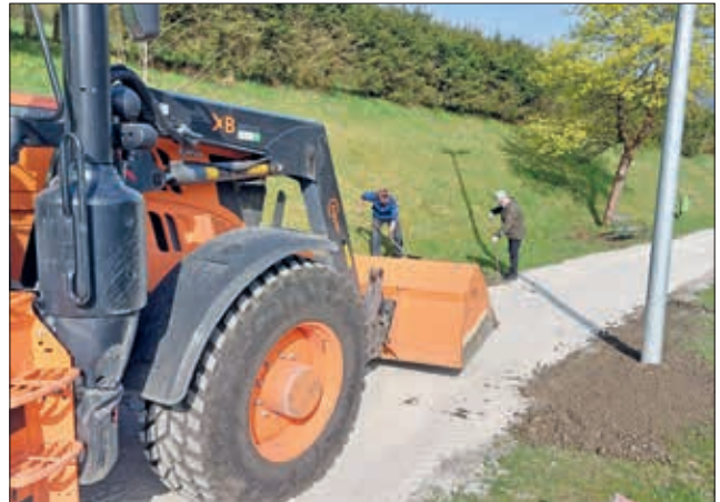
Arbeiten am Freizeitsee
