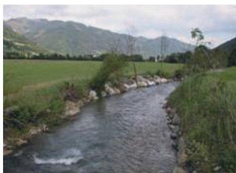
Fertigstellung Hochwasserschutzprojekt Liesing
