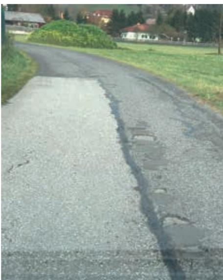
So wurde der bestehende Straßenbelag profiliert, worauf eine neue Asphalt-schicht aufgebracht wurde. Diese Sanierungskosten in der Höhe von
