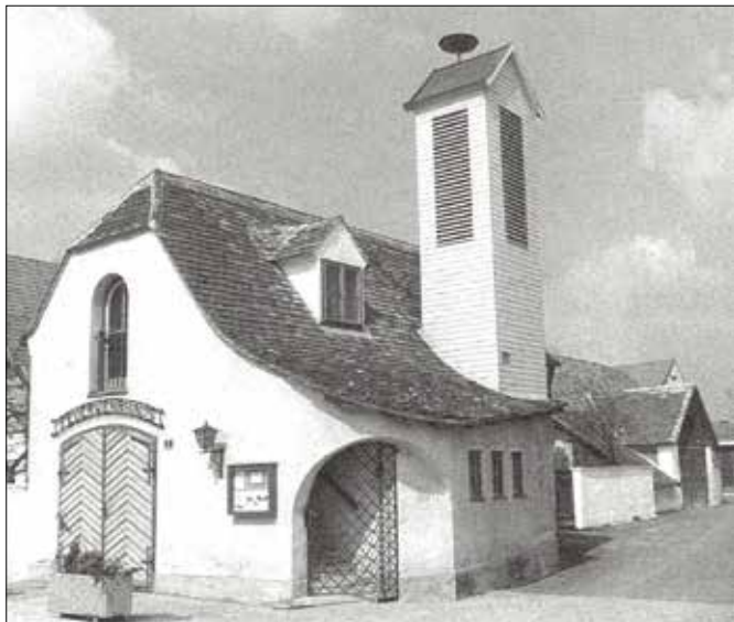
Altes Feuerwehrhaus am Hauptplatz – erbaut 1952
