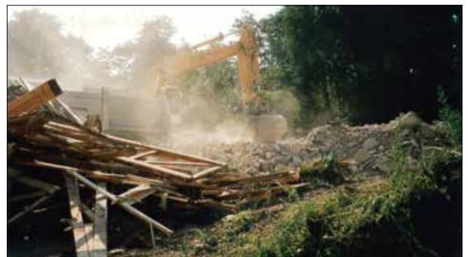
Abriss altes Kindergartengebäude
