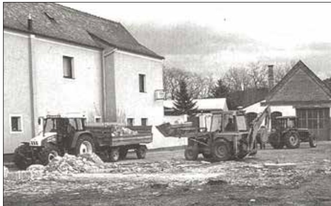
Beginn Neubau Feuerwehrhaus Hauptstraße - 1998
