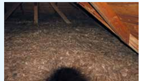
TEILWEISE DACHBODEN-DÄMMUNG IN DER VOLKSSCHULE
