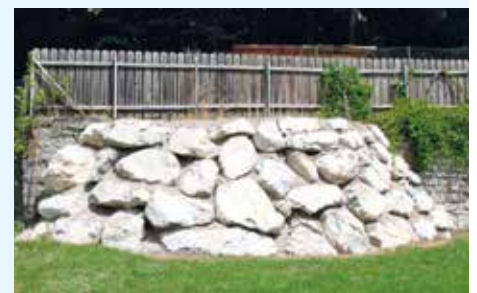
MAUERSANIERUNG BEIM GEMEINDEAMT
