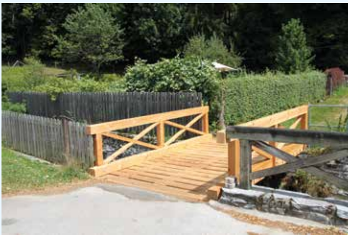
BRÜCKENSANIERUNG BEI SCHWAIGER UND KLARMANN
