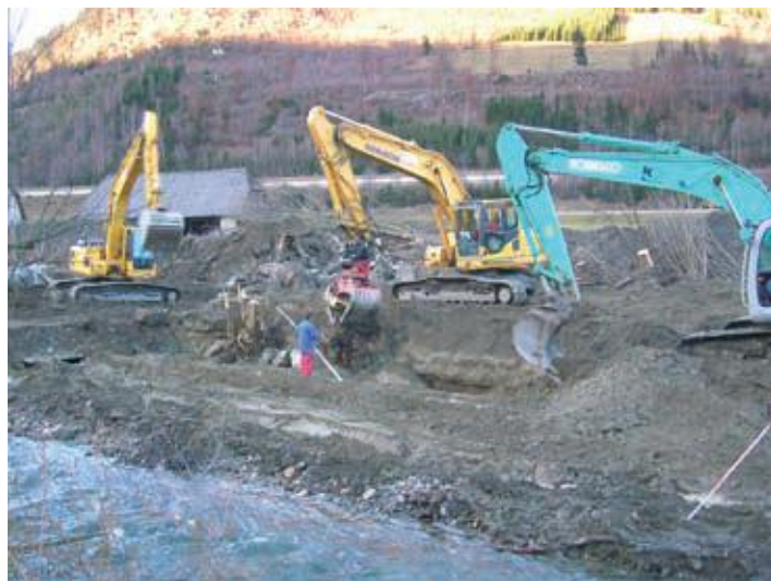
Herstellung der neuen gesicherten Ufer im Bereich Dörfli, Fam. Schober
