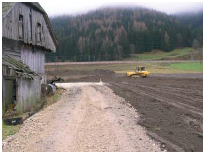
Herstellung der Abflussection im Bereich Fam. Zechner
