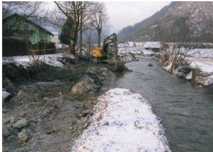
Einbau rechtsufriger Steinsicherungen im unteren Abschnitt Dörfli
