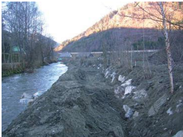
Neues linkes Ufer im Bereich Dörf l mit umgesetzt em Bewuchs
