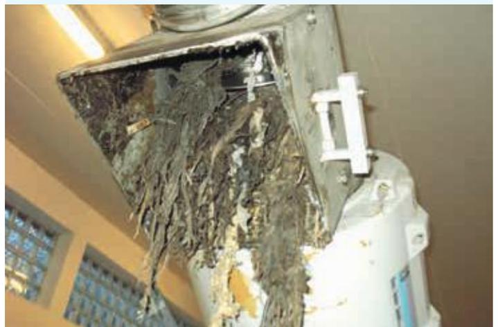
Leider kommt es immer wieder vor, dass es aufgrund der Entsorgung von Restmüllgegenständen über die Kanalisation zu einem Stillstand der Zulaufschneckenpumpe kommt. Um diese Schnecke wieder in Betrieb nehmen zu können, muss der Klärwärter in mühseliger Geduldsarbeit die einzelnen Fremdkörper entfernen. Dadurch entstehen auch zusätzliche Kosten.
