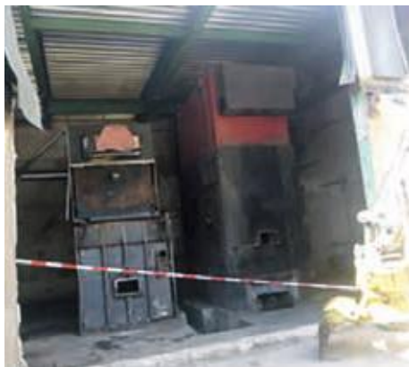
Abbruch alte Kesselanlage August 2018
