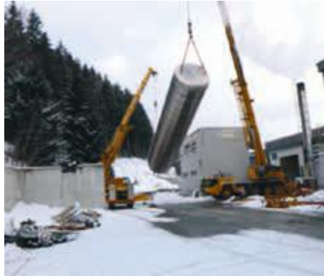
Installation Fernwärme-Pufferspeicher Dezember 2018
