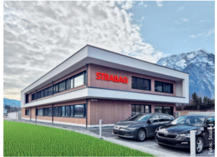
Die neue Strabag-Zentrale in Trautenfels
