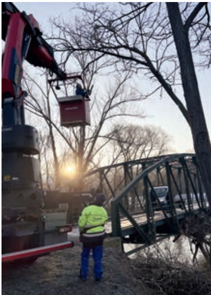
Kranarbeiten bei der Altenhofer Brücke
