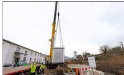
Die zwölf Tonnen schwere Gasdruckregelmessanlage schwebt mithilfe des Mobilkrans auf das vorbereitete Fundament.
