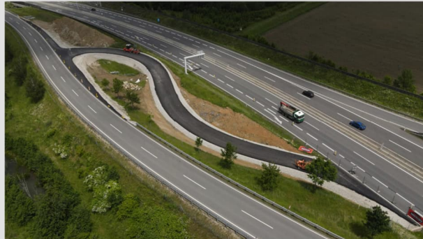
Bild 1: provisorische Auffahrtsrampe auf die S10 RFB Linz
