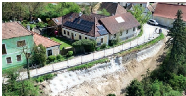
Hangsicherung in Stiefern mit Spritzbetonversiegelung
