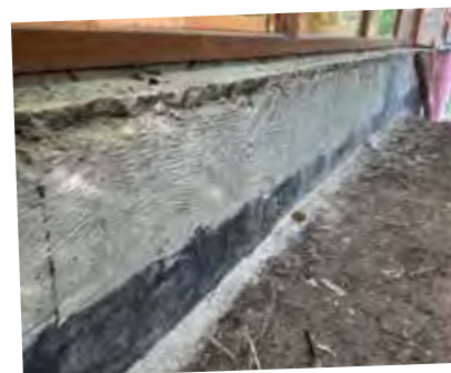
laufen die Vorbereitungen zur Dämmung.
