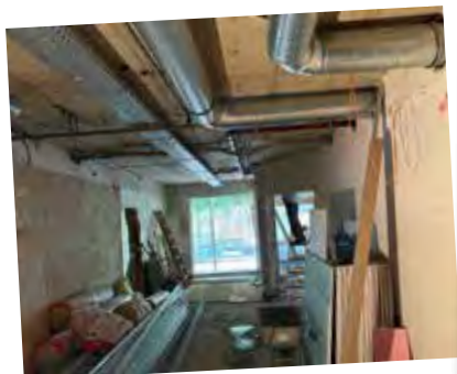
Böden und Decken wurden abgetragen
