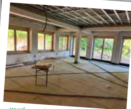
wurden entfernt und zum Teil bereits wieder eingebaut.
