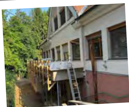
Mit den Arbeiten am Vordach im Bereich
