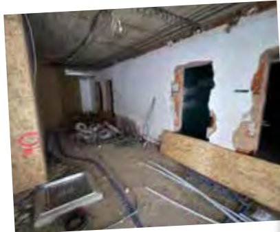
Türen und Fenstern im Untergeschoß
