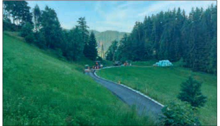
Für die **Asphaltierung des Kirchbergweges** (B-Weg und Hiabler-Jöstl-Weg) wurde der Unterbau bereits in den letzten Jahren neu errichtet. Die Asphaltierung war erforderlich, da der Unterbau bei größeren Regenereignissen regelmäßig beschädigt wurde. Die Durchführung der Asphaltierungsarbeiten wurden vom Amt der Steiermärkischen Landesregierung - Abteilung 7 - ausgeschrieben und an die Fa. STRABAG AG vergeben.
