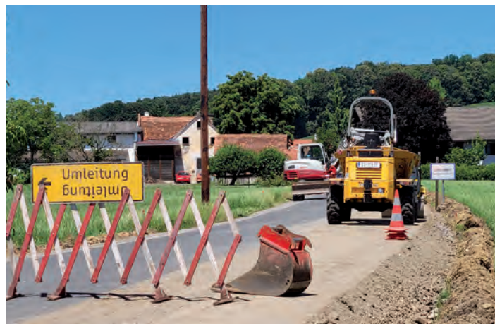
Straßensanierung Mühlfeldweg in Johnsdorf Foto: Stadtgemeinde Fehring
