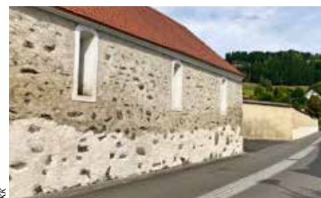
Neu sanierte Stiftsmauern
