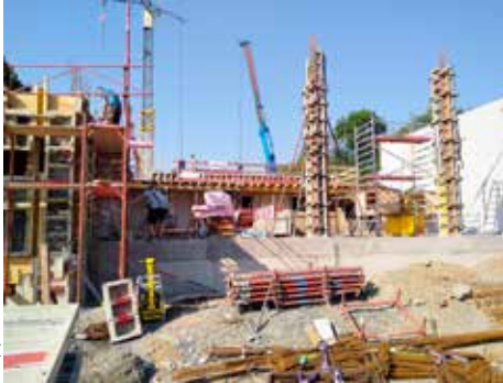
Vor einem Jahr noch Baustelle, heute ist das Rüsthaus schon einsatzbereit.
