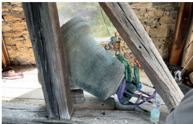
Um Kosten zu sparen, sanierten Freiwillige die Glocke im Schönberger Kirchturm. Herzlichen Dank dafür.
