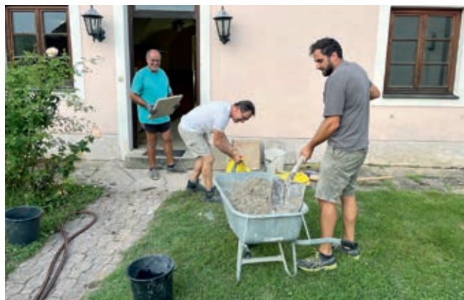
Ehrenamtliche übernahmen viele Arbeitsleistungen bei der Sanierung des Schönberger Pfarrhofes.
