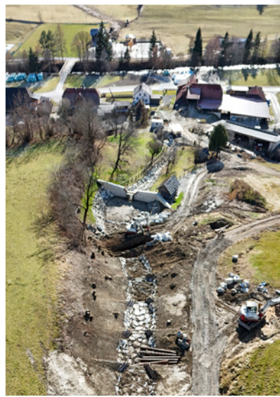
Hochwasserschutz-Verbauung Kotwegerbach
