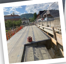
Seebachbrücke – Brücke wurde saniert, verbreitert und um einen Gehweg erweitert
