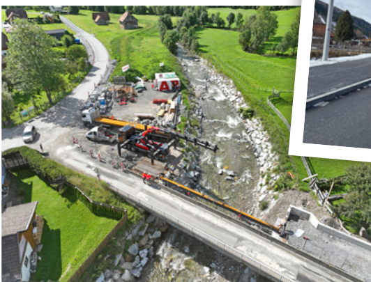
Seebachbrücke – Brücke wurde saniert, verbreitert und um einen Gehweg erweitert
