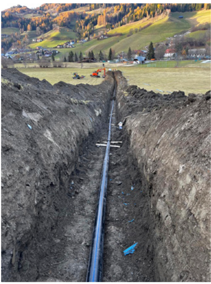
Hauptwasserleitung Ranten – 360 m Leitungsrohre wurden erneuert
