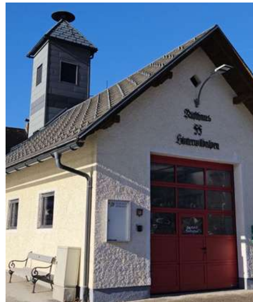
Das Rüsthaus mit der erneuerten Fassade des Schlauchturms
