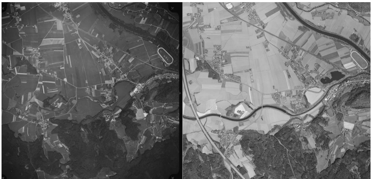
Abbildung 8: Historische Luftbilder Wildon, Weitendorf, Lichendorf: 1971 (links) und 1975 (rechts). Die Umfahrung Lichendorf im Bau in der Bildmitte des rechten Fotos. (Quelle: GIS Steiermark)
