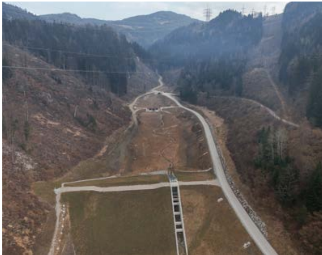
Hochwasserschutz im Tollinggraben
