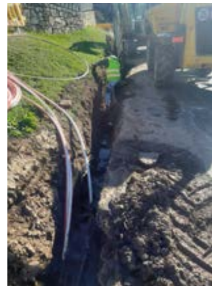
Die Grabungsarbeiten sind abgeschlossen.
