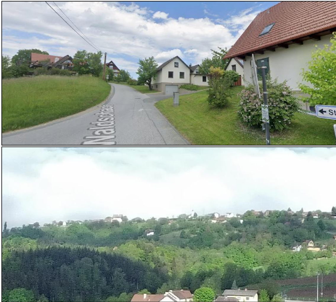
Abbildung 76 – W2, Blick von der Gemeindestraße (Google StreetView) sowie eigene Schrägluftbildaufnahme
