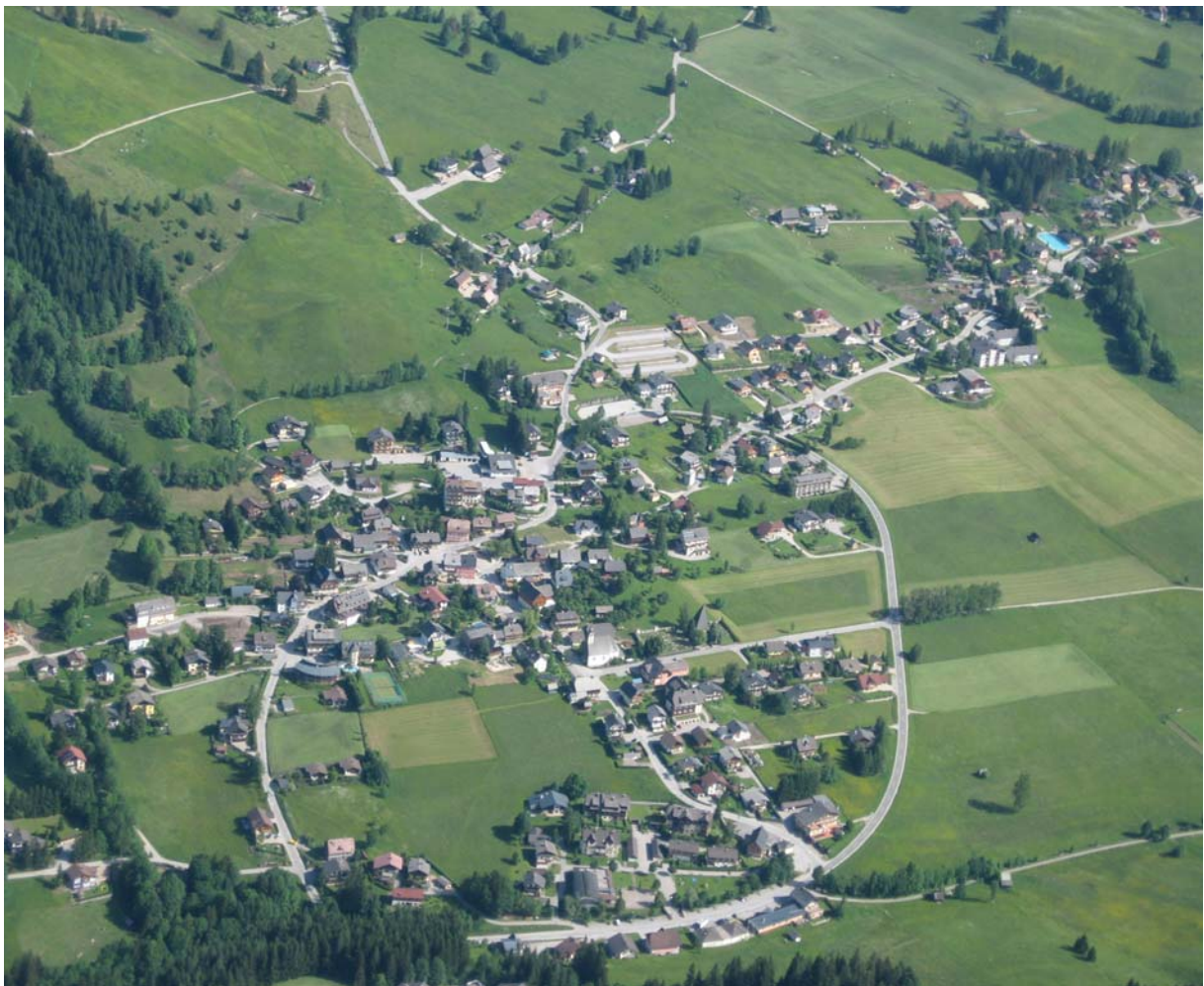
Tauplitz-Ort, Ansicht von Süden, 2009
