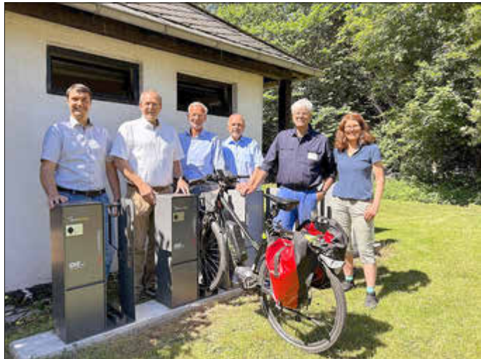
Florian Schmidt, Oberbürgermeister Frank Frühauf, OIE Vorstand Thomas Johann, Bürgermeister Friedrich Marx, Jörg Hofrath und Julia Besand (v. l.) freuen sich, dass die gemeinsam neu geschaffenen Ladepunkte an der Weiherschleife nun genutzt werden können.
