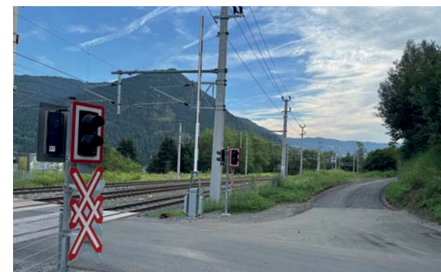
Eisenbahnkreuzung Panoramastraße und neu asphaltierte Gemeindestraße
